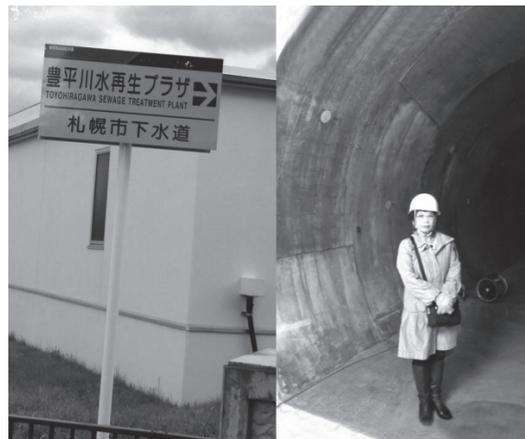
白石区北郷・平和通地区の「浸水被害の軽減」「合流式下水道の改善」を目的とした下水道施設として、水再生プラザと中継ポンプ場間2km、地下10～15m地下ルートに直径4mの貯留管を築造しており、最大24,000m<sup>3</sup>を貯留できる。
