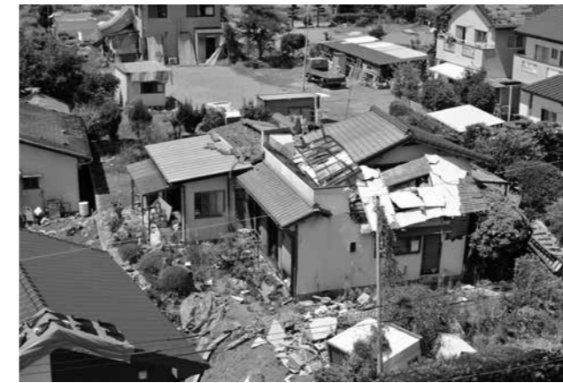
半壊状態の建物とブルーシートの並み
